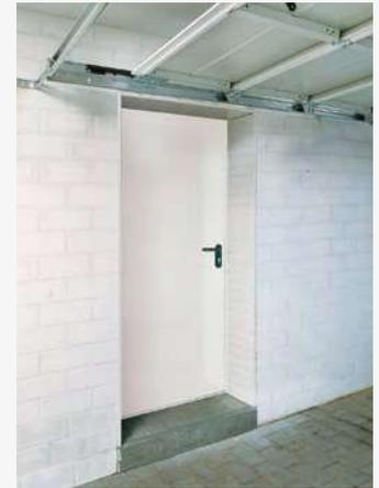
**Stahl-Feuerschutztür H3-1 OD**
